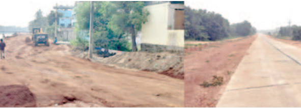
కొత్తగా నిర్మించిన స్వర్ణముః రోడ్డు,గిరిప్రదక్షిణ రోడ్డు దృశ్యం
